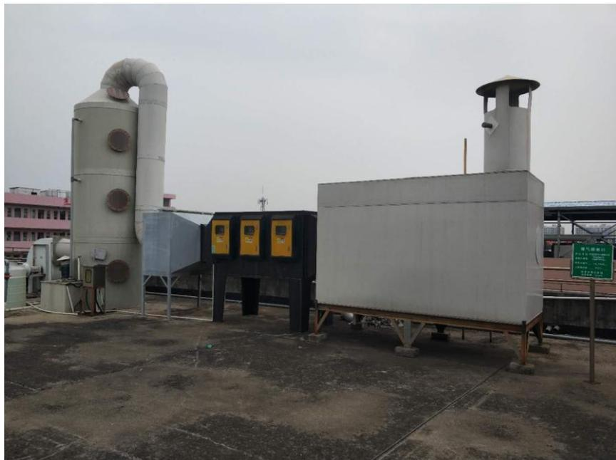
图 4-7 有机废气处理设施
