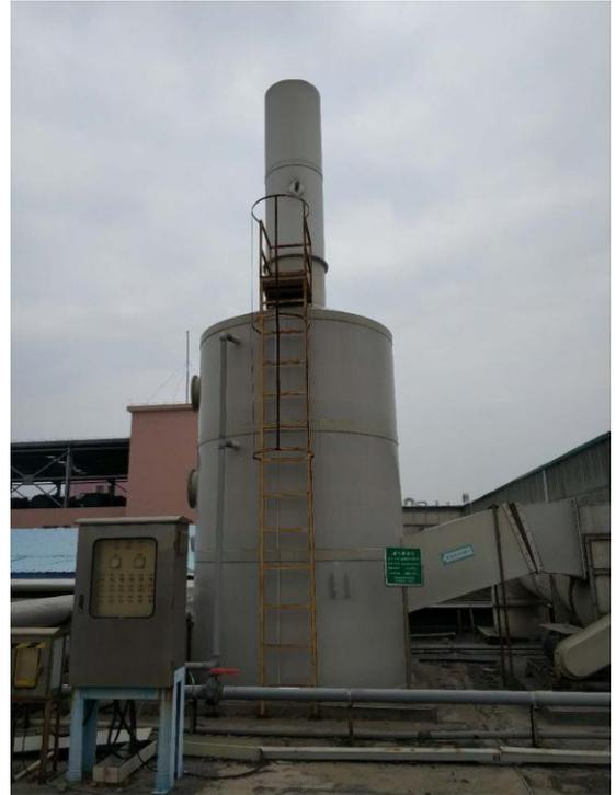
图 4-6 酸雾废气处理设施
