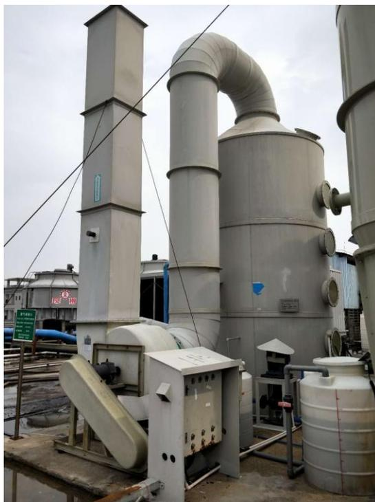
图 4-4 氯化氢废气处理设施
